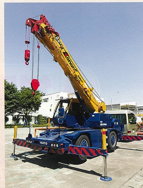
移動式クレーン
